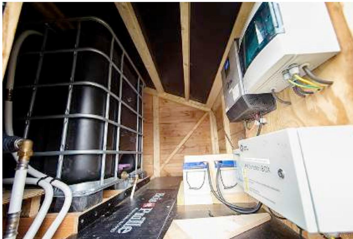
En cas de situation où un raccordement au réseau d'eau ne serait pas possible, il est prévu de pouvoir raccorder la « tiny house » à une réserve d'eau ainsi qu'à un système autonome de filtration des eaux grises. De plus la forme de ce véhicule offre une surface de 5.60m<sup>2</sup> permettant l'installation de panneaux photo-voltaïques.
